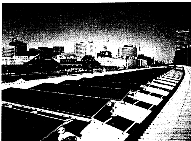
東京駅太陽光発電パネル
