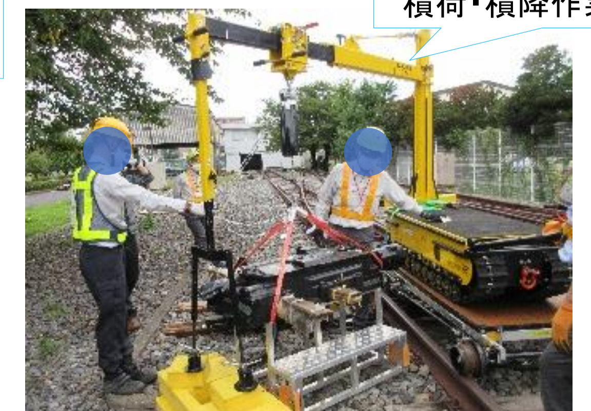
オンレール状態での施工 積荷・積降作業(作業2名)
