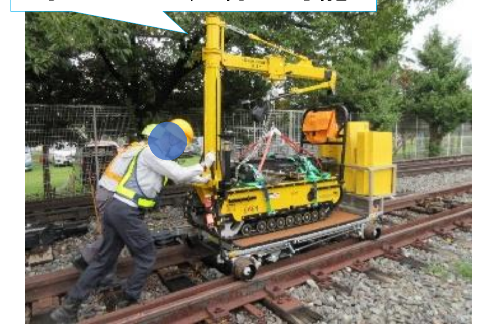
オンレール状態での施工 積荷・積降作業(作業2名)
