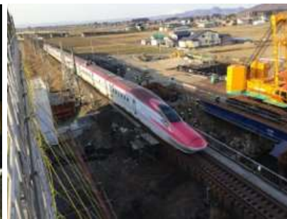
架設後の列車通過状況
