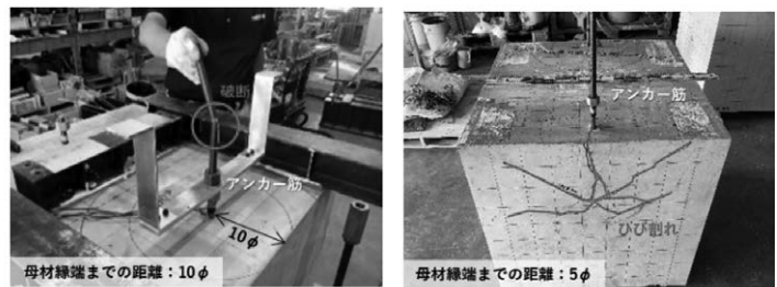
a) アンカー筋の破断
