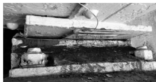
図11 支点部へのライナープレートの挿入状況
