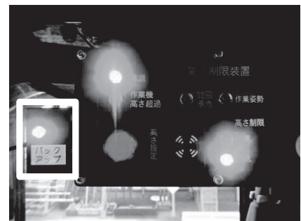
図7 バックアップ動作確認機構(表示灯)
