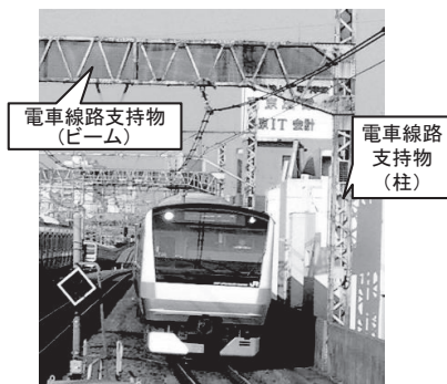
図1 電車線路支持物
