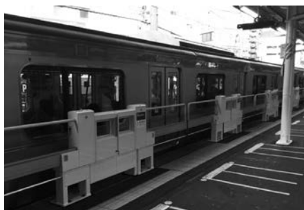
写真7 スマートホームドア®（横浜線町田駅）
