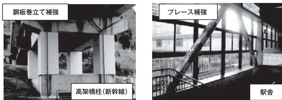
写真2 耐震補強例
