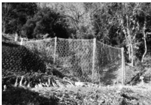
図2 高エネルギー吸収柵による土砂流入量の低減対策
