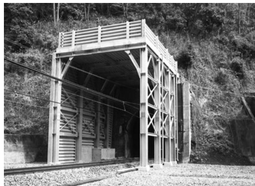
図4 覆い工による落石対策
