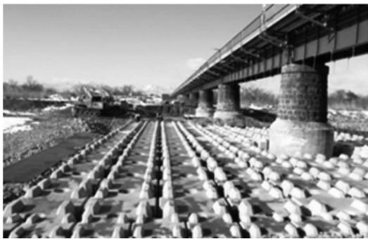
図5 コンクリートブロックによる洗掘対策
