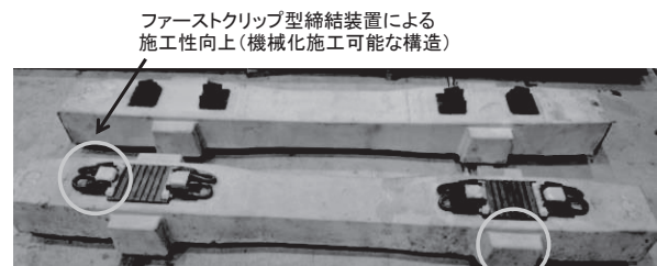
羽根構造による道床横抵抗力向上
