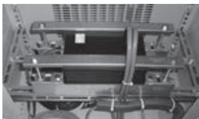
図2 直流変流器
