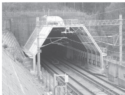
図2 ダクト付きトンネル緩衝工
