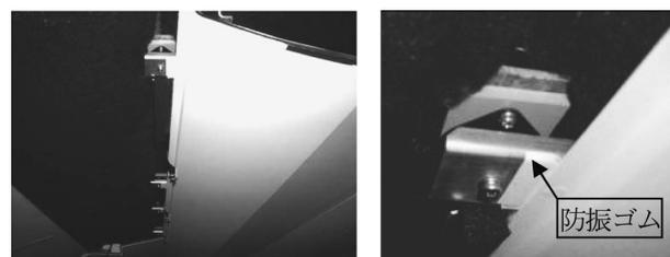
図4 弾性支持による天井構造
