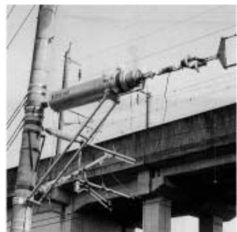
図3：ばね式バランサー
