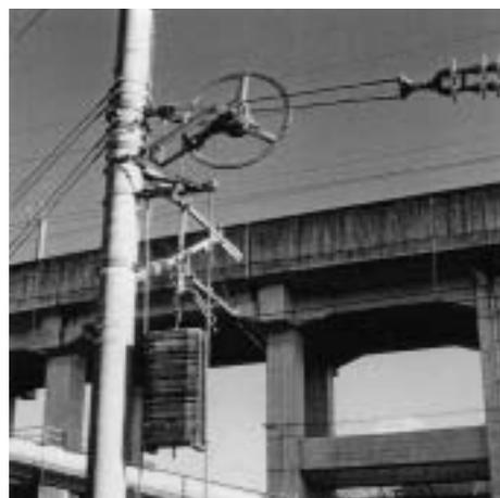
図2：滑車式バランサー
