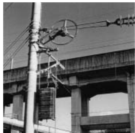
図2：滑車式バランサー
