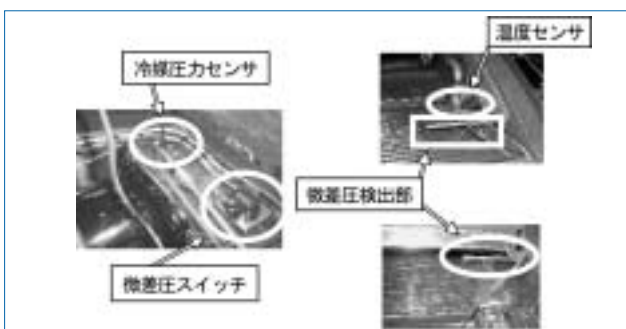
図7：目詰まり検知用センサ取付
