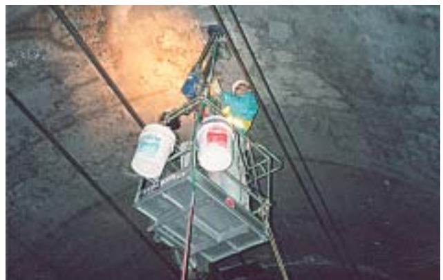
図8：コンクリート覆工ボーリング
