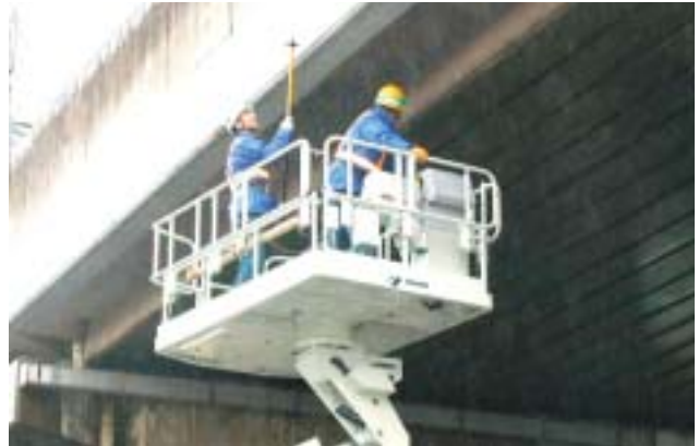
図7：高架橋のだ音検査
