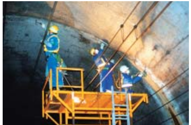
図14：至近距離目視、打音検査
