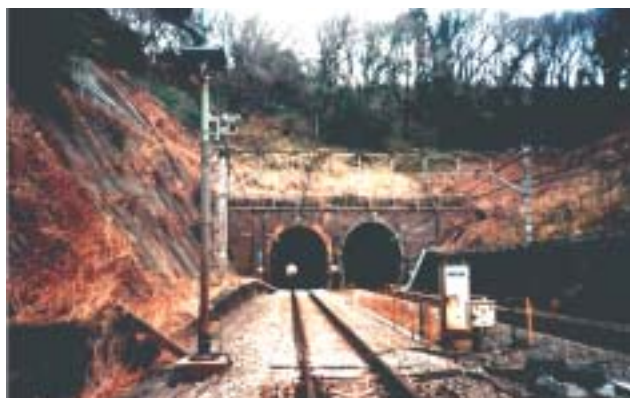
図1：東海道線清水戸トンネル(1887年建設) 鉄道営業線で最古のレンガトンネル(左側)
