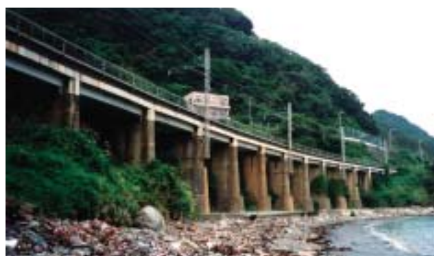
図2：内房線山生(やもめ)橋りょう
