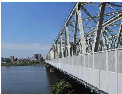
総武線 平井～新小岩 (荒川・中川橋りょう)
