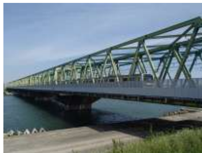
総武線 小岩～市川 (江戸川橋りょう)
