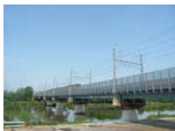
武蔵野線 南越谷～吉川間 (中川橋りょう部)
