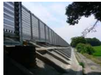
川越線 指扇～南古谷間 (荒川橋りょう付近)
